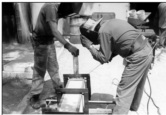
Figura 5. Procedimiento de soldado de las soleras precalentadas
