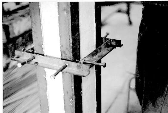
Figura 4. Colocación de los ángulos con un anillo de acero
