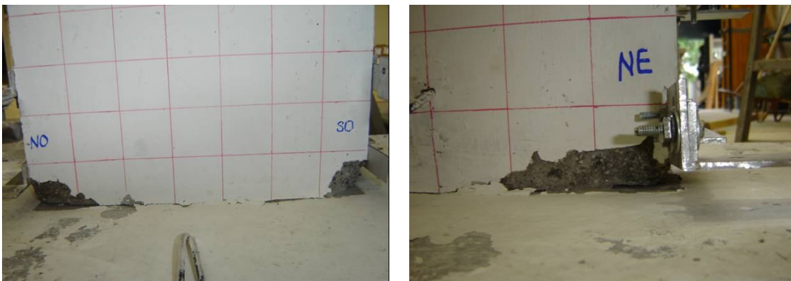
(b) Espécimen A1, daños en base de muro después del ensaye de intensidad máxima aplicada
