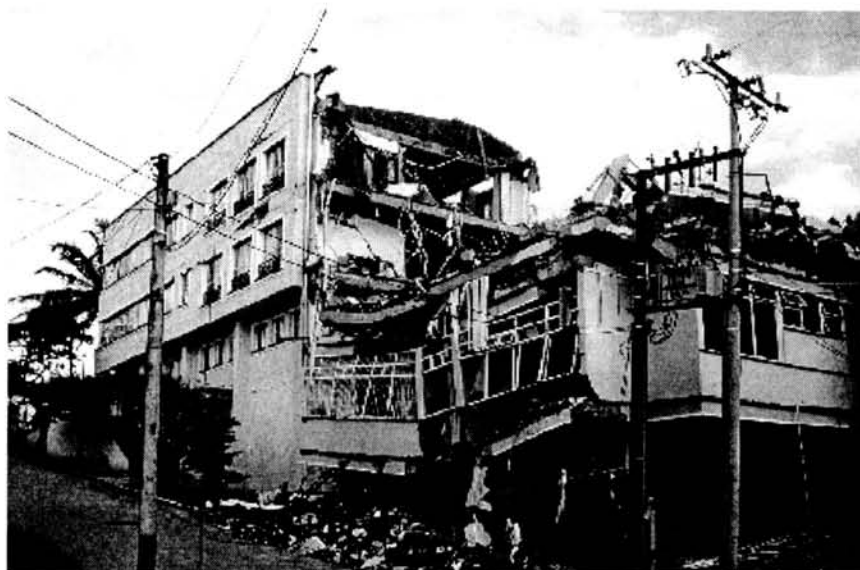
Foto 19 Edificio antiguo de la Policía en el cual perdieron la vida varios agentes (Cardona)
