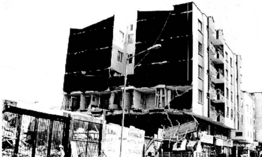
Foto 15 Caída de muros de tabiquería de fachada por flexibilidad de la estructura (Cardona)
