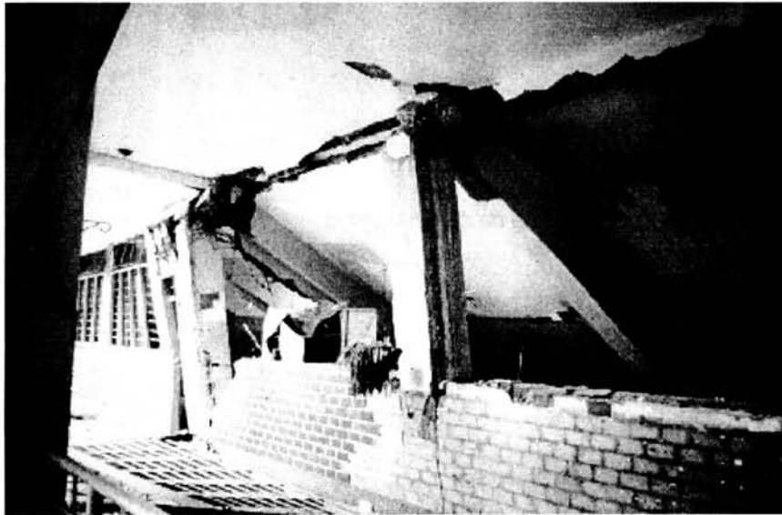
Foto 10 Falla de nudos de unión viga-columna por falta de refuerzo trasversal (Cardona)
