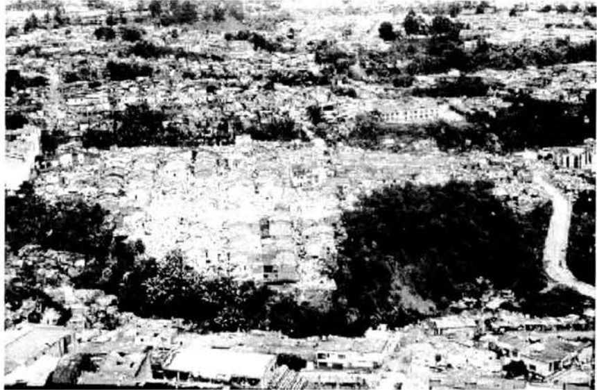
Foto 1 Destrucción del Barrio Brasilia localizado sobre una colina (Ingeominas)
