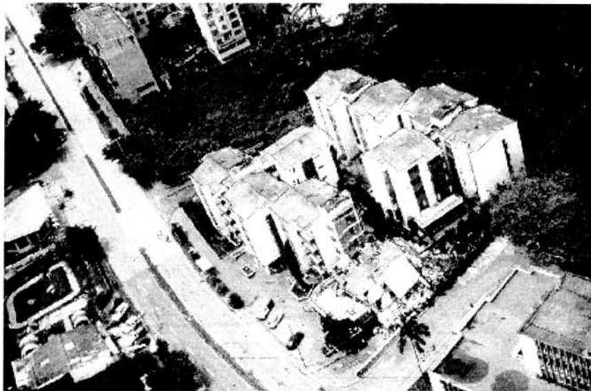
Foto 2 Colapso de edificio moderno en la zona norte de Armenia (Ingeominas)
