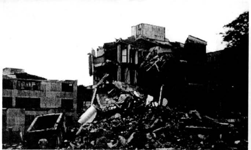
Foto 6 Colapso parcial de edificio con tanque superior de grandes dimensiones (Cardona)
