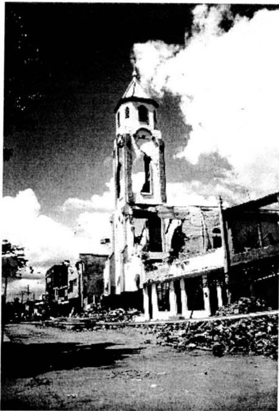
Foto 21 Daños severos en la Iglesia del corregimiento de Barcelona (Cardona)
