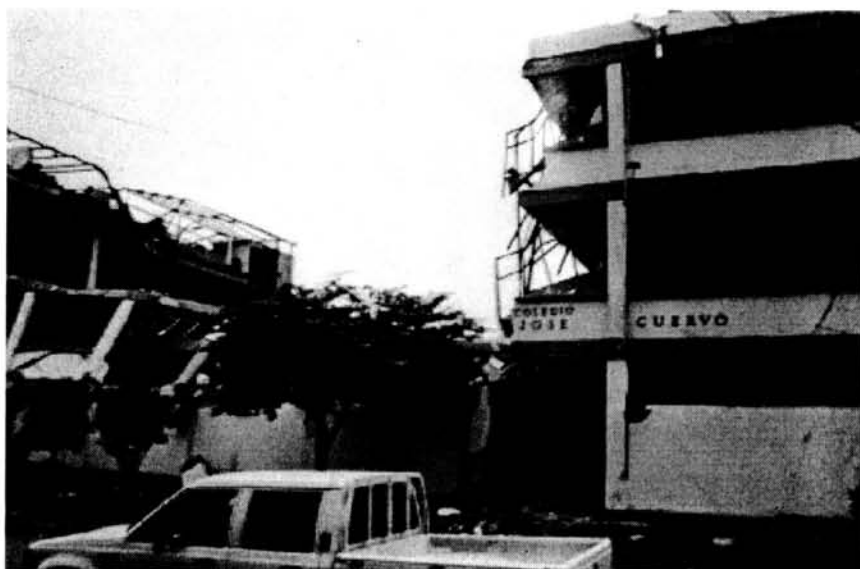
Foto 18 Colapso parcial de edificación del sector educativo por columnas cortas (Cardona)
