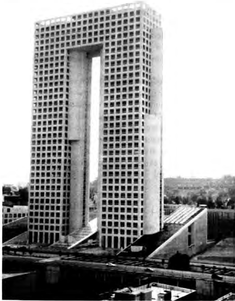
Fig 11. Edificio Arco I
