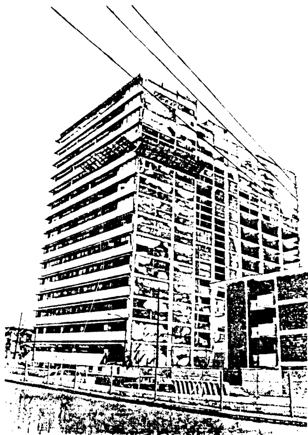
a) Fotografía del edificio después del temblor
