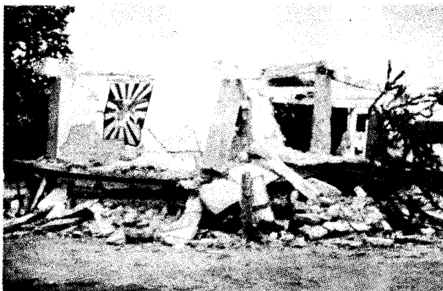
Fig 31 Colapso de una escuela por columna corta y agregados de mala calidad y de tamaño excesivo.
