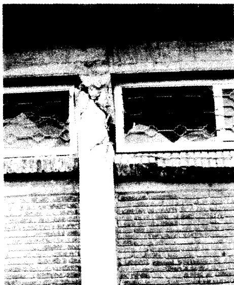
Fig 30 Falla por cortante en columna corta. Nótese que el muro está rematado con una dala ligada a la columna.
