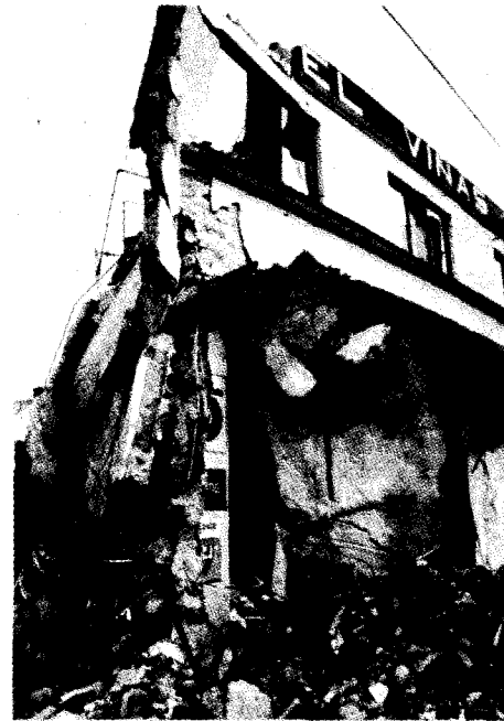
Fig 28 Colapso de la estructura por falta de continuidad en elementos estructurales y concreto pobre.
