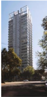
a) Vista general, edificio estudiado
