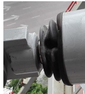
Figura 6. Amortiguadores después de la ocurrencia del sismo del 19 de septiembre de 2017
