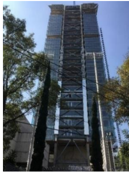
a). Fachada del edificio, 28 de septiembre de 2017.
