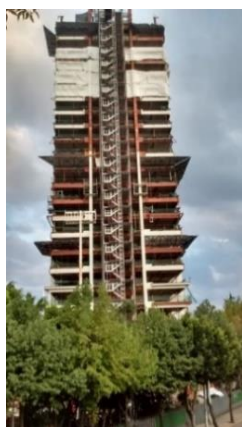
a). Fachada del edificio, noviembre de 2016.
