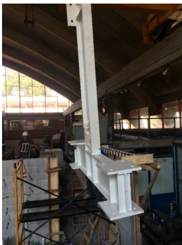
a) Traslado con grúa
