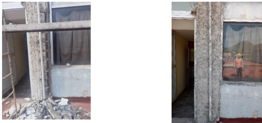
Figura 35. Columna del nivel 2, justo en la entrada-salida al patio.
