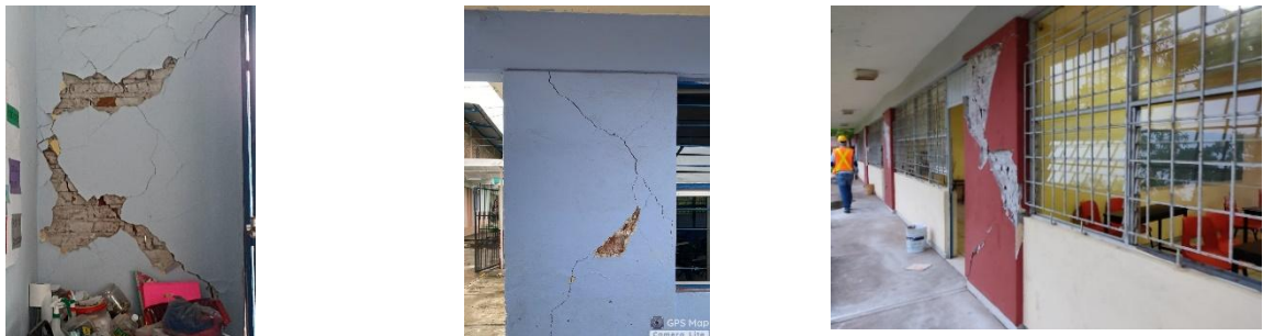
Figura 12. Daños típicos por tensión diagonal en estructuras con muros de carga de tabique o tabicón
