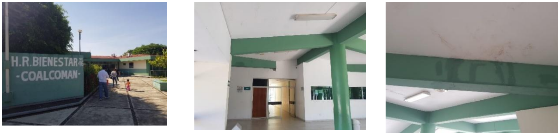
Figura 30. Entrada principal del Hospital Regional 46, IMSS y vista del sistema estructural.
