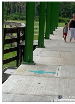
Figura 19. Agrietamiento en pisos de patios y salones de clase
