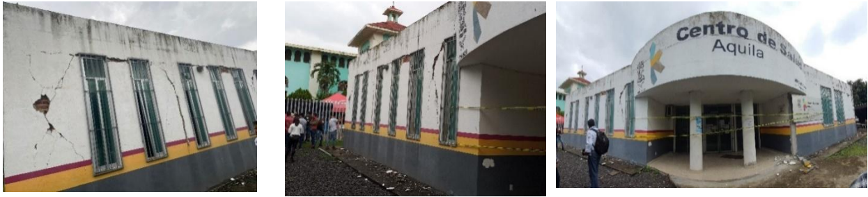
Figura 21. Fachada principal del Centro de Salud de Aquila.
