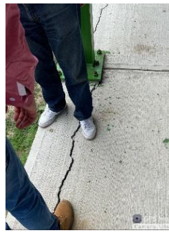
Figura 19. Agrietamiento en pisos de patios y salones de clase
