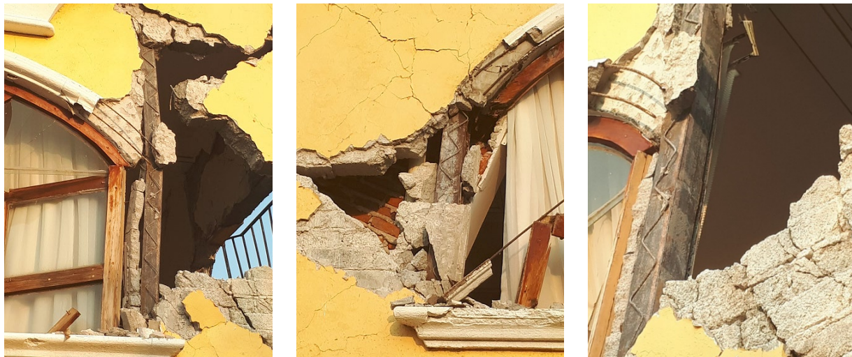
Figura 16. Uso de perfiles de acero como elementos confinantes de muros
