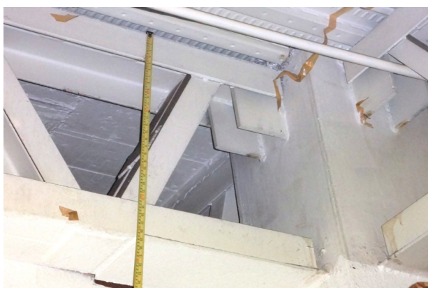
Figura 2. Conexión típica trabe - columna
