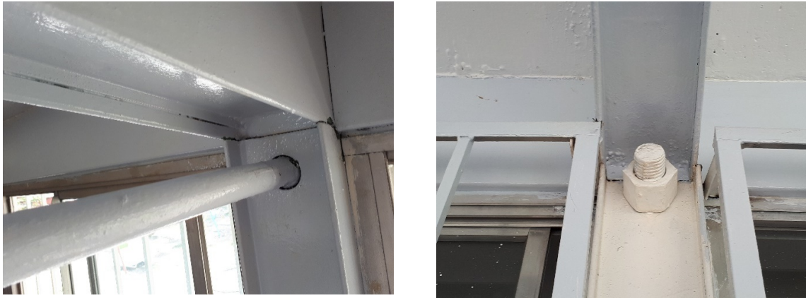
Figura 12. Conexión típica del redondo de acero
