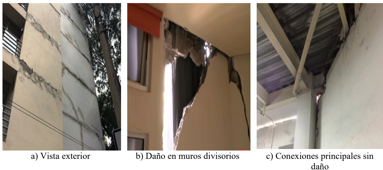
Figura 17. Edificio en la Ciudad de México
