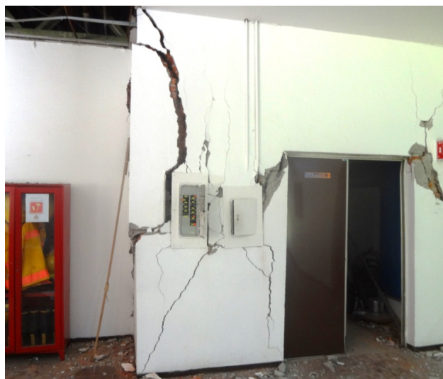
Figura 3. Daño en los principales muros de la estructura
