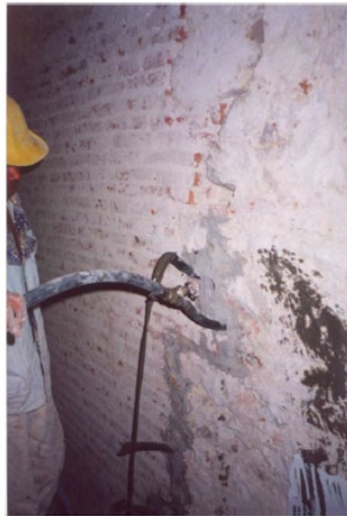
Figura 7. Inyección de grietas en muros
