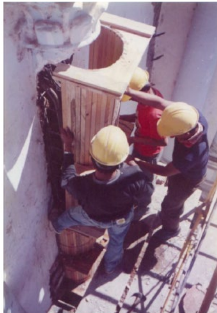
Figura 11. Restauración de las columnas de la fachada
