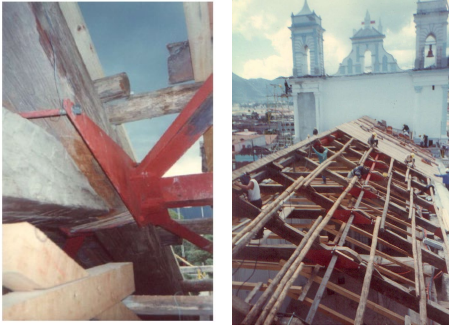
Figura 10. Rehabilitación de techumbre con estructura metálica
