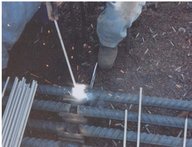
Figura 1. Soldadura de varillas
