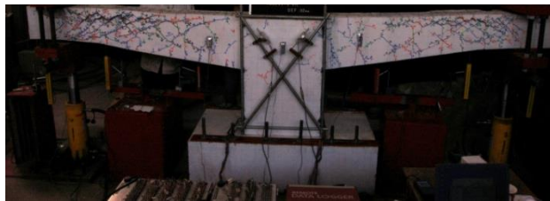
a) Patrón de agrietamiento último
